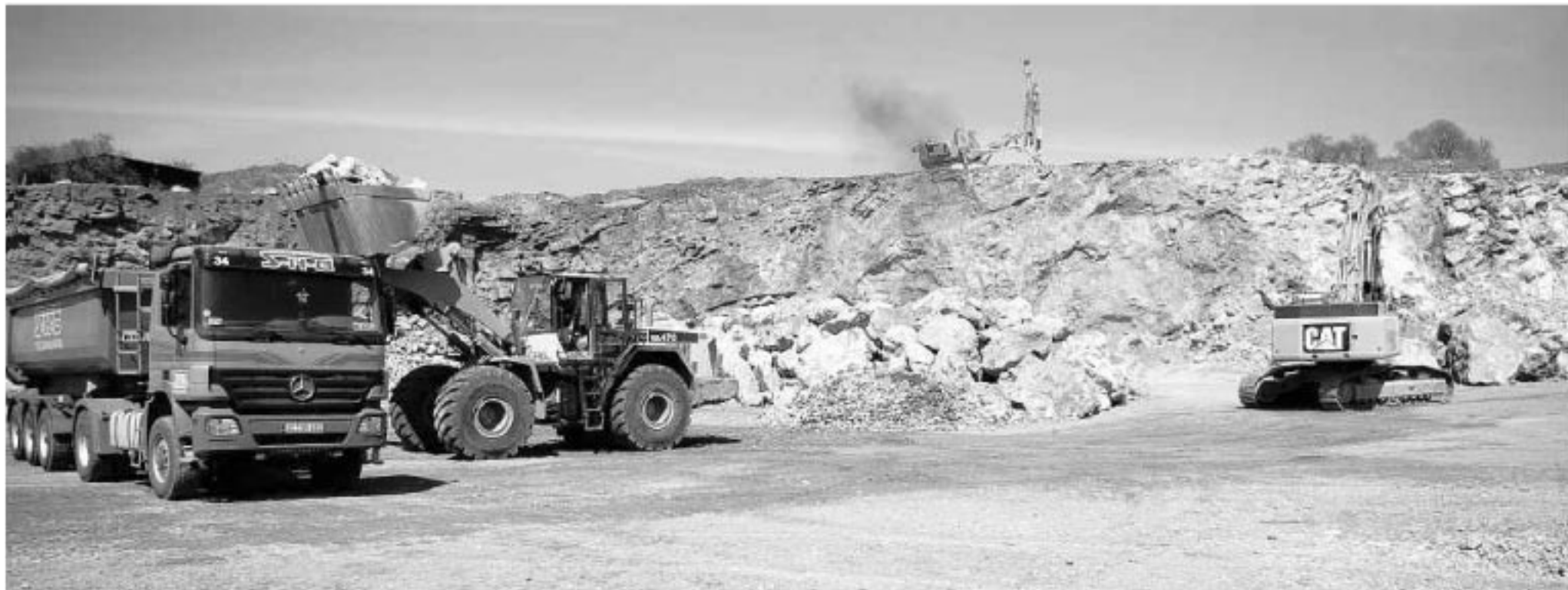
Werkverkehr soll reduziert werden: Der Umbau einer Mahl- zu einer Splittanlage im Steinbruch Breinig soll den BSR-Pendelverkehr nach Gressenich minimieren.
