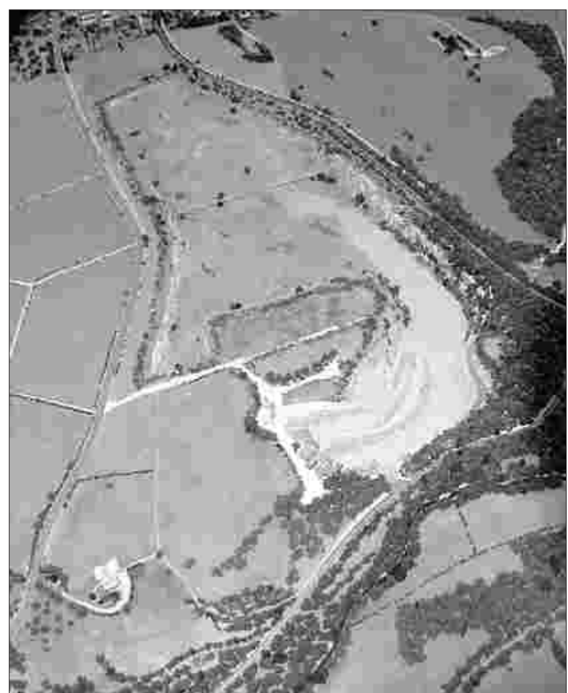
Das zukünftige Abbaugelände: Vom Steinbruch Blees aus wird sich das Abbaugelände zwischen der Landesstraße 12 und der Bahnlinie bis 300 Meter vor die Breiniger Ortsgrenze (oben im Bild) erstrecken.
